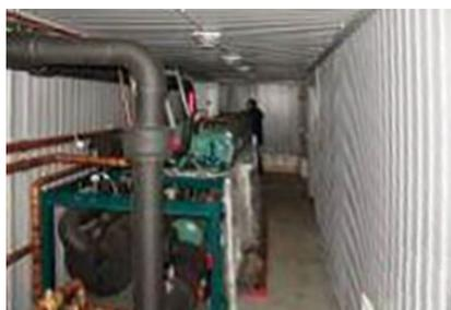
Представляют собой агрегатированное машинное отделение в габаритах **40 футового контейнера** полной заводской готовности
