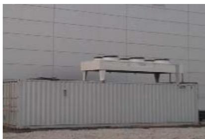
Представляют собой агрегатированное машинное отделение в габаритах **40 футового контейнера** полной заводской готовности
