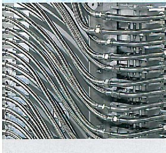
Гибкие тефлоновые шланги для R22, армированные нержавеющей сталью и индивидуально испытанные под давлением. Гибкие шланги из нержавеющей стали для R717, индивидуально испытанные под давлением. Штуцеры из нержавеющей стали
